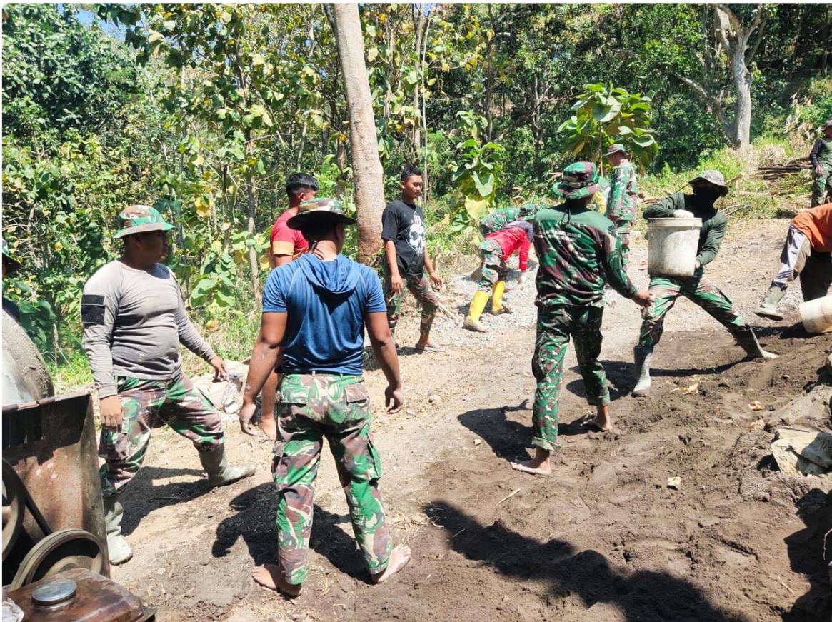
"Betonisasi jalan saat ini dalam tahap intensif, dengan tim yang bekerja secara maksimal untuk menyelesaikan pekerjaan sesuai jadwal. Aktivitas ini termasuk persiapan permukaan, pengecoran beton, dan perawatan agar hasilnya optimal," kata Kades.
